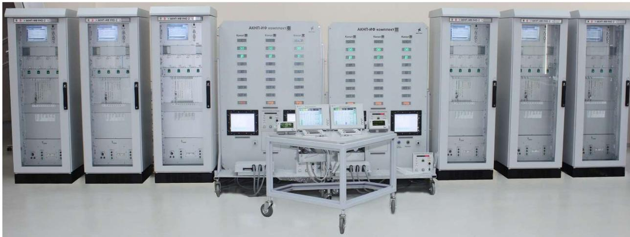
Аппаратура контроля нейтронного потока АКНП-ИФ входит в состав системы управления и защит (СУЗ) энергоблоков АЭС.
