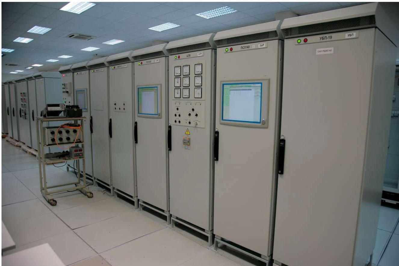
САУ РДЭС - одна из основных частей систем аварийного электроснабжения всех каналов системы безопасности энергоблока АЭС. САУ РДЭС совместно с другими смежными системами обеспечивает управление пуском, подключением к сети и работой на мощности дизель-генераторной установки ДГУ, управление возбуждением и защитой генератора, управление оборудованием собственных нужд и вспомогательным оборудованием.
