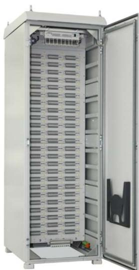
Шкафы дискретных сигналов ШДС могут быть установлены парно с идентичной компоновкой для их взаимного резервирования.
